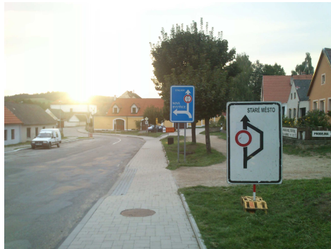
Příklad plochy Hradebního okruhu - nutná obnova po ukončení stavebních prací
