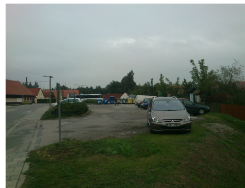
Pohled na provozně i prostorově nevyhovující plochy parkoviště a autobusového nádraží
