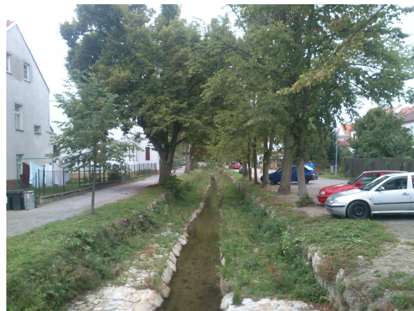
Pohled na koryto potoka protiproudu v zastavěné části města - koryto po opravě
